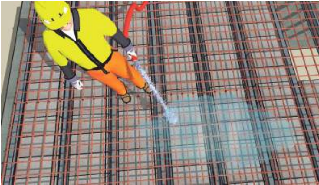
Figura 42 Verificación de armaduras y mojado previo al colado
